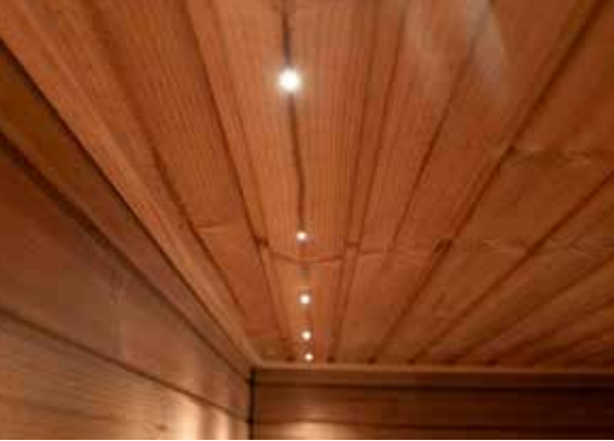
Tunnelmavalistus, kuituvalaisimet kattoon asennettuna
