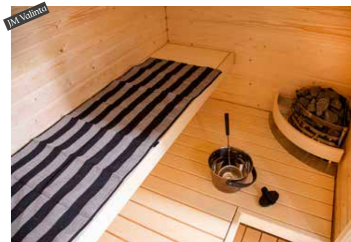
Saunan seinä- ja kattopaneelit kuusta, lauteet sekä kiukaan suojakaide haapaa
