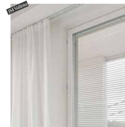
Kaksiosainen, valkoinen verhokisko asennettuna kaikkien ikkunoiden kohdalle. Lisäksi sälekaihtimet asennettuna kaikkiin ikkunoihin.
