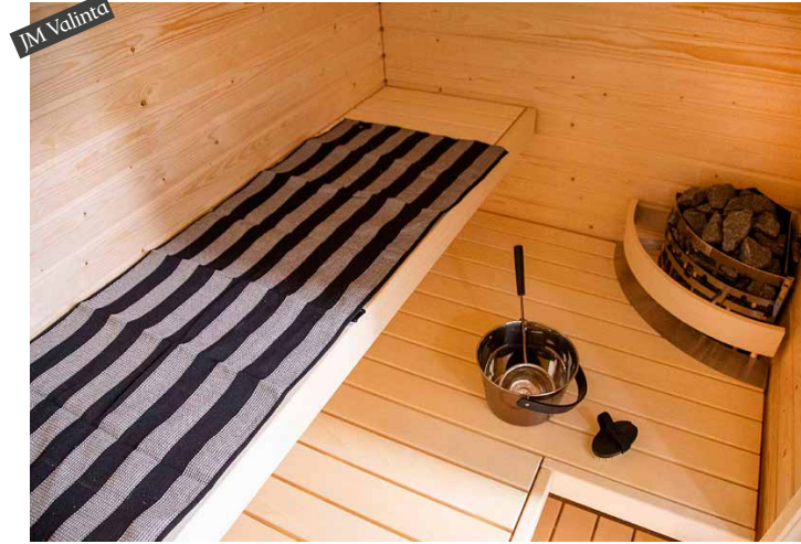
Saunan seinä- ja kattopaneelit kuusta, lauteet sekä kiukaan suojakaide haapaa
